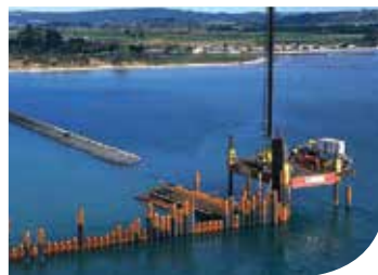
Projeto: terminal de contêiner Local: Nova Zelândia Produto: Sistema HZM
